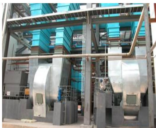
秦皇岛热电厂循环流化床一、二次风机
