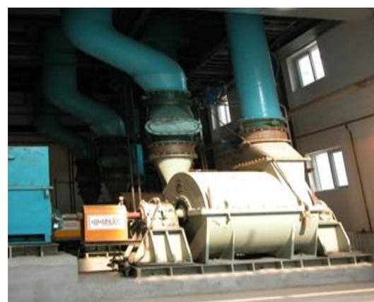
秦皇岛热电厂高压流化风机
