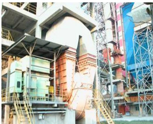
华新水泥日产 5000 吨干法水泥线原料磨风机
